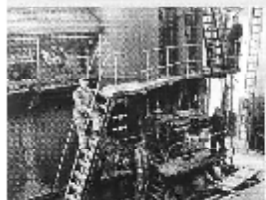
Montés à l'ouvrage, le 17 décembre 1931 (Archives EEF)
