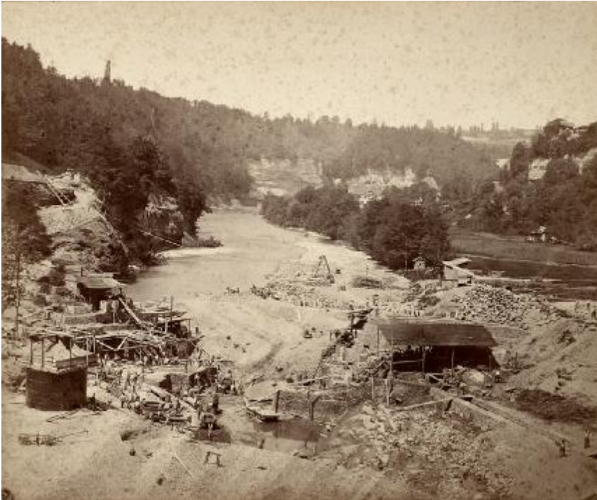
Construction du Barrage de la Maigrauge, aménagement du chantier, entre 1870 et 1872
