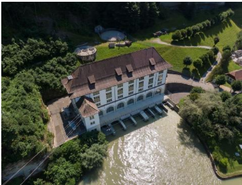
L'usine de l'Oelberg. Photo : groupe-e.ch
