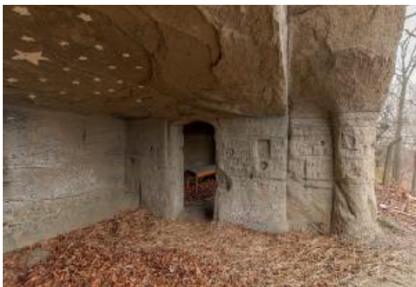
Fig. 10. Fribourg. Ermitage de Bourguillon. Vue depuis la grande salle en direction de la pièce de repos de l'ermite. Photographie L. Bender.
