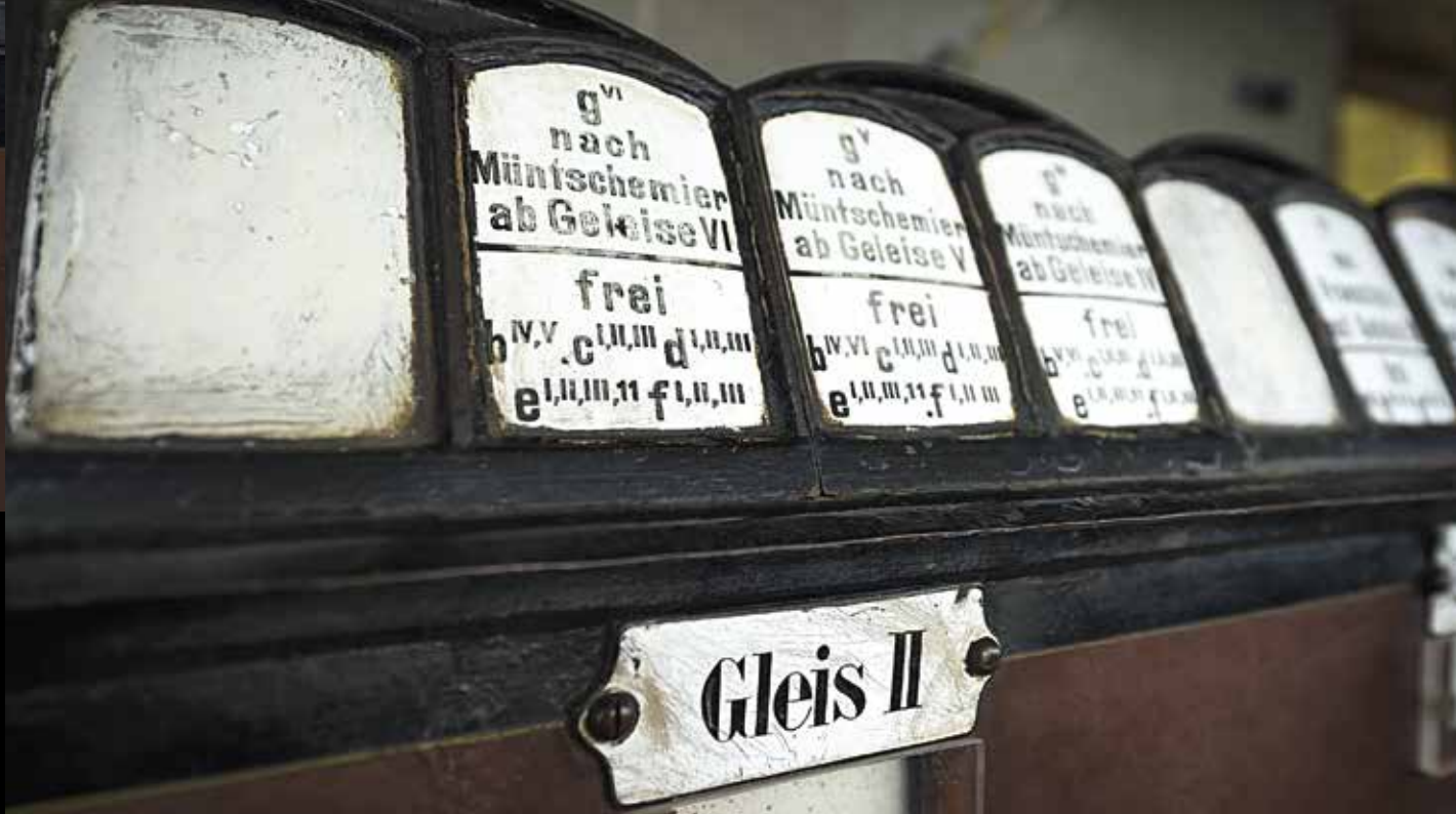
Poste d'aiguillage de Chiètres Dès 1901, le poste d'aiguillage de Chiètres a géré le nœud ferroviaire de ce qui était alors le seul croisement de Suisse avec un angle aigu exceptionnel de 30 degrés, sur les lignes Lyss-Palézieux et Berne-Neuchâtel. Dès lors, un poste mécanique de commande et d'autorisation ainsi qu'un appareil d'enclenchement avec aiguilleur furent créés pour régler la circulation des trains. Cette installation est restée en service jusqu'en octobre 2004, avant son arrêt définitif suite à l'arrivée de l'électronique. Son parfait état de fonctionnement est désormais maintenu dans un musée grâce à l'association Verein Stellwerk Kerzers.
