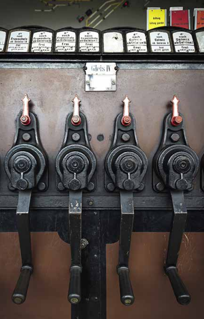
Poste d'aiguillage de Chiètres Dès 1901, le poste d'aiguillage de Chiètres a géré le nœud ferroviaire de ce qui était alors le seul croisement de Suisse avec un angle aigu exceptionnel de 30 degrés, sur les lignes Lyss-Palézieux et Berne-Neuchâtel. Dès lors, un poste mécanique de commande et d'autorisation ainsi qu'un appareil d'enclenchement avec aiguilleur furent créés pour régler la circulation des trains. Cette installation est restée en service jusqu'en octobre 2004, avant son arrêt définitif suite à l'arrivée de l'électronique. Son parfait état de fonctionnement est désormais maintenu dans un musée grâce à l'association Verein Stellwerk Kerzers.
