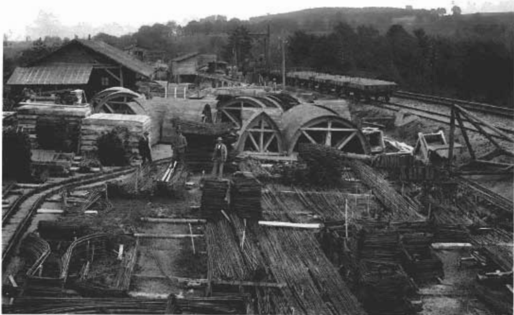
Sur le sommet de la falaise, côté Fribourg: l'entreposage des fers à béton et des coffrages. Transport de sable sur la voie de service. A remarquer la variété de forme des coffrages.
