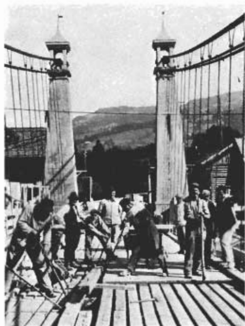
Ci-dessus: La démolition du tablier du pont suspendu le 5 octobre 1931.
