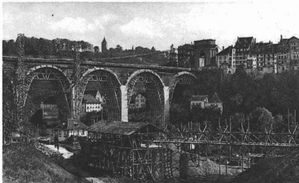
1884 FRIBOURG - Travaux du Pont de Zaehringen - (Vue prise le 26 Août 1923)
