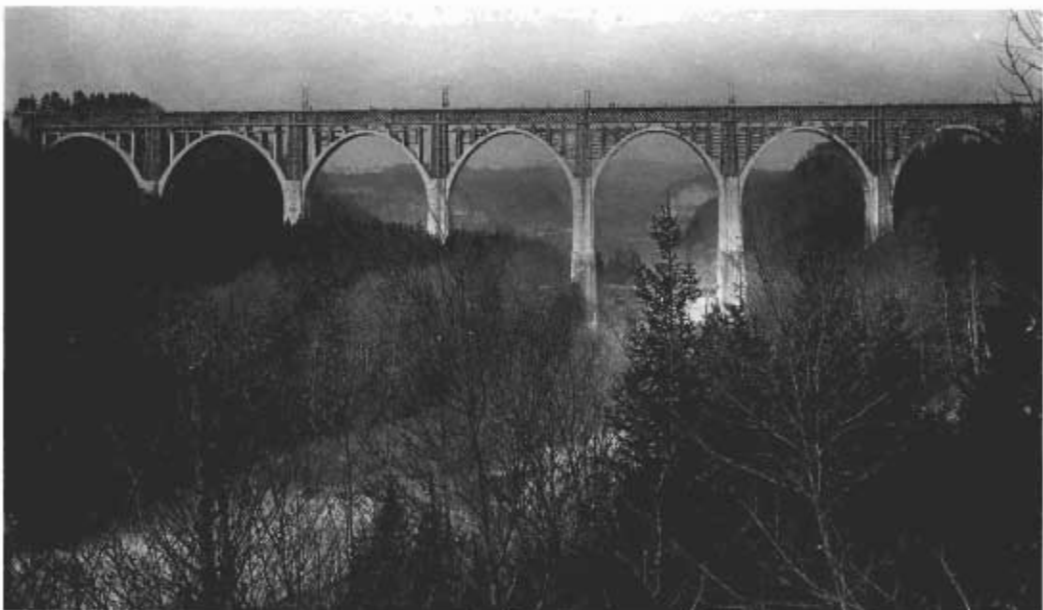
Le pont au printemps 1926: les arcs "Melan" sont terminés. Sur leurs voûtes, se construit les arcatures sur lesquelles le tablier reposera. Les parties hautes des anciens piliers métalliques sont encore bien visibles.
