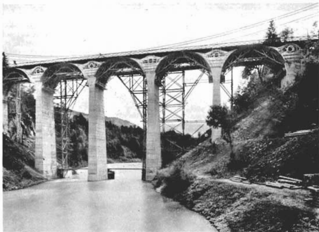
Ci-dessous: vue d'ensemble du chantier le 23 août 1931.
