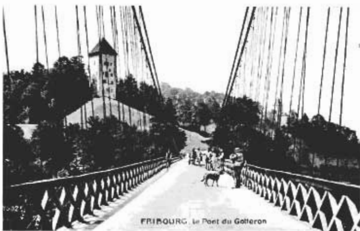
Le pont et la tour de Dürrenbühl dans l'entre-deux-guerres
