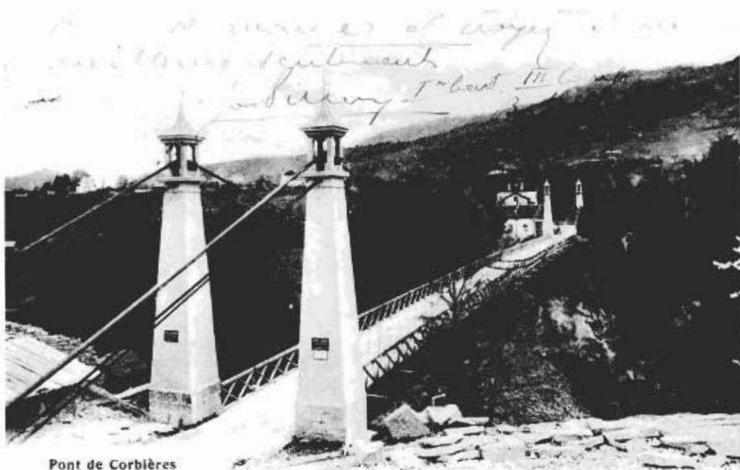
Pont de Corbières
