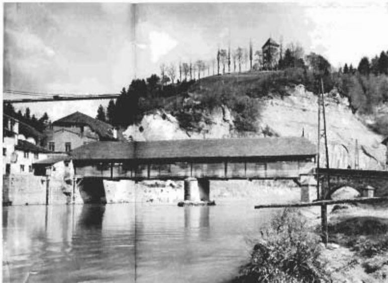
Le pont de bois de Fribourg est le plus ancien à avoir gardé sa physionomie d'origine. Il est l'un des ornements de Vieux Fribourg. Sur cette photo prise vers 1900, il apparaît dans son complet développement, avec les deux arches côté ville, actuellement surcraquées par la voie d'accès au parking du quartier. A l'arrière-plan, la silhouette effilée du pont de Gouttron souligne l'audace de nos anciens ponts suspendus. (photo archives Pro Fribourg)
