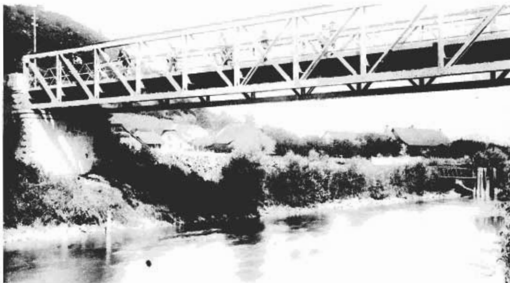
Le pont sur la Broye près de Sugiez, une simple passerelle en poutrelles métalliques avait remplacé en 1874 un pont couvert en bois. Le nouveau pont en béton de 1967 l'avait rendu sans objet. Sa démolition a eu lieu peu après.
